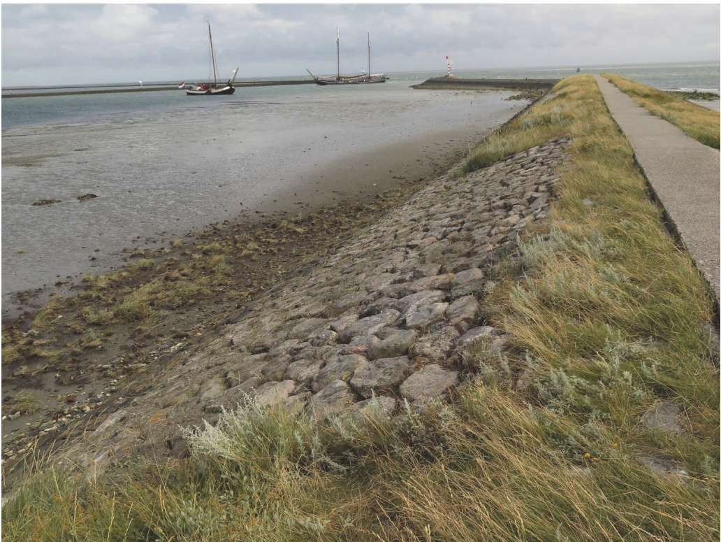
De door Thijs van Trigt herstelde dijk langs de havenkom van Terschelling.
