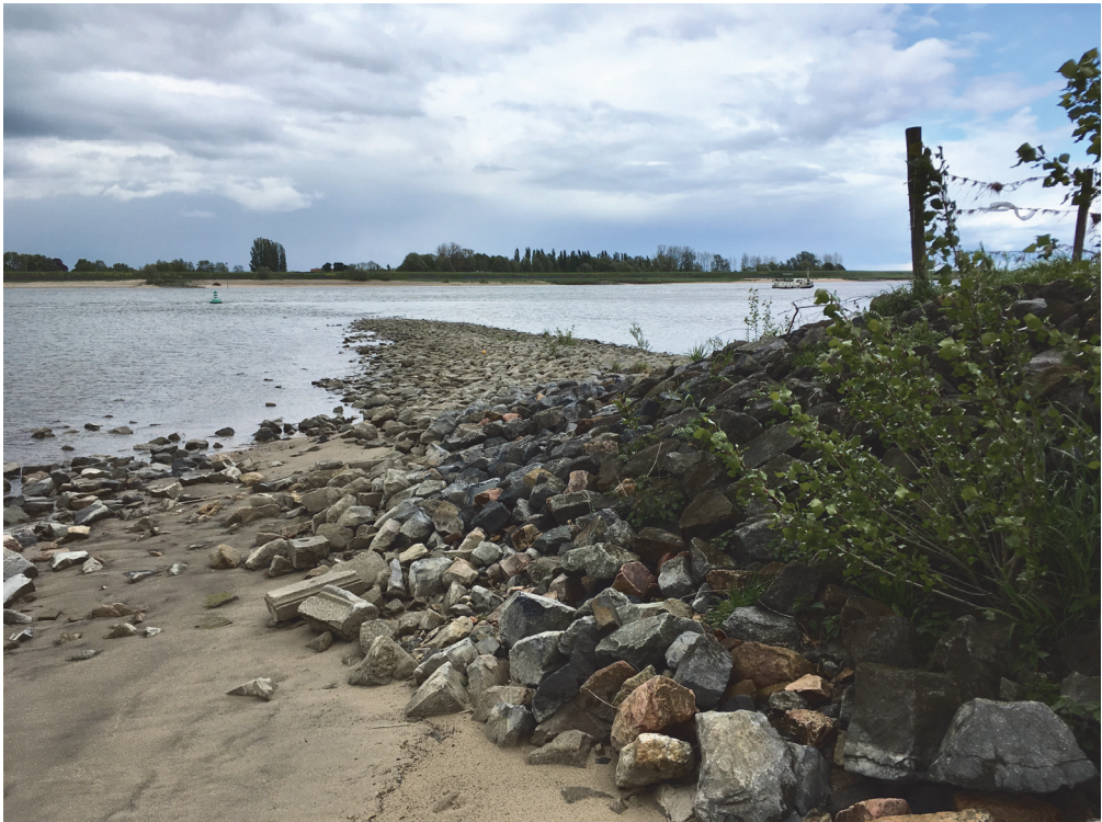
Afbeelding 2. Een verlaagde krib. Rechts in beeld is de oorspronkelijke hoogte van de krib zichtbaar.
