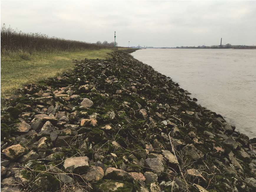
Afbeelding 5. Oeverbeschoeiing van kwartsietstenen bij Beneden-Leeuwen. Rijk begroeid met onder andere Didymodon nicholsonii , Cinclidotus fontinaloides en – zeldzaam – Dialytrichia mucronata var. mucronata .
